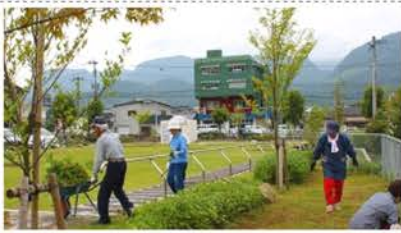
くすふれあい公園の作業の様子
